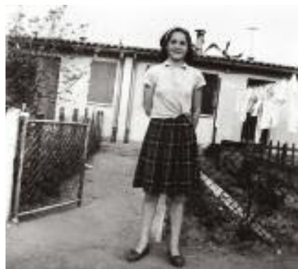
Cité d'urgence des Oiseaux, Athis-Mons, années 1950. Après l'appel de l'abbé Pierre en faveur des sans-logis (1954), des cités d'urgence sont édifiées sous forme de pavillons en bandes. 3
