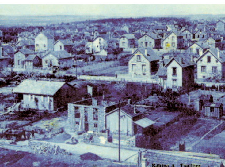
Le quartier des Cherchefeuilles, Savigny-sur-Orge, années 1930. Suite aux lois de 1928, le quartier est aménagé (voirie, réseaux électriques) et des pavillons économiques, de type Loucheur, se construisent. 23
