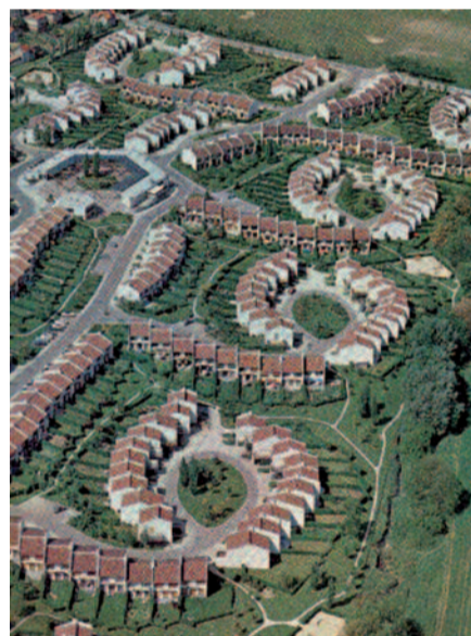
Le Hameau de la Roche à Ris-Orangis (1971), exemple de lotissement en raquette, une nouvelle forme de quartier pavillonnaire. 13
