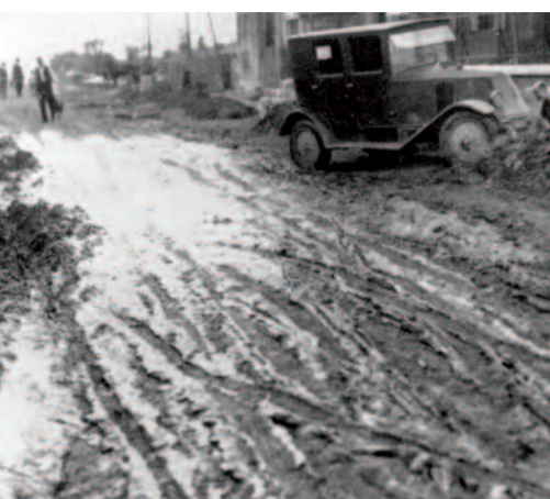
La rue de la Pompe à Athis-Mons en 1929. L'accès à la propriété pavillonnaire se fait au milieu des pires difficultés. 22
