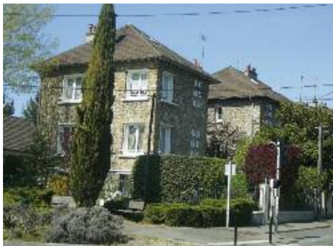
Pavillon Reconstruction, Athis-Mons, 2010. Le quartier du Val est détruit par les bombardements alliés visant la gare de triage d'Athis-Juvisy au printemps 1944. Les pavillons sont rebâti en meulière associée à des éléments préfabriqués en béton armé : cadres de bloc de fenêtre, auvents, pergolas, colonnes pour le porche.
