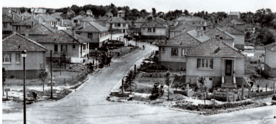
Cité Guynemer, Brétigny-sur-Orge (années 1950). La période de la Reconstruction est l'occasion pour les architectes d'expérimenter de nouveaux procédés de construction et modèles de quartiers.
