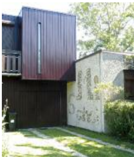
Maison de Villagexpo, Saint-Michel-sur-Orge, 1966. Ce concours est créé par l'État pour favoriser le renouveau du pavillonnaire. 26
