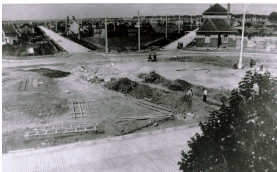
Construction des routes dans les lotissements de Paray-Vieille-Poste par l'entreprise locale de travaux publics Graticola, dans les années 1930, suite à la loi Sarraut.
