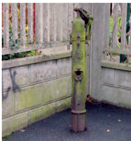
Une pompe à eau, vestige des années 1930 à Savigny-sur-Orge. En l'absence de réseau de distribution, on s'approvisionne en eau grâce à ce type de pompe manuelle, caractéristique des lotissements de l'entre-deux-guerres. 13
