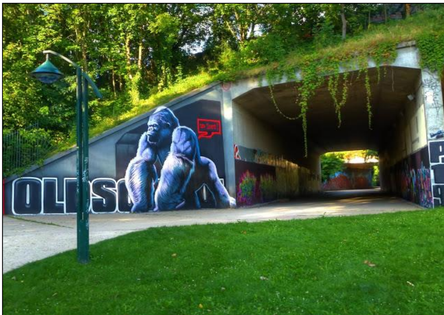
Passage souterrain sous l'A6 à Villebon-sur-Yvette. Photo Dominique Leriche.
